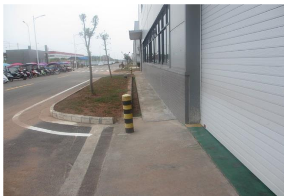
主体建筑区排水沟
