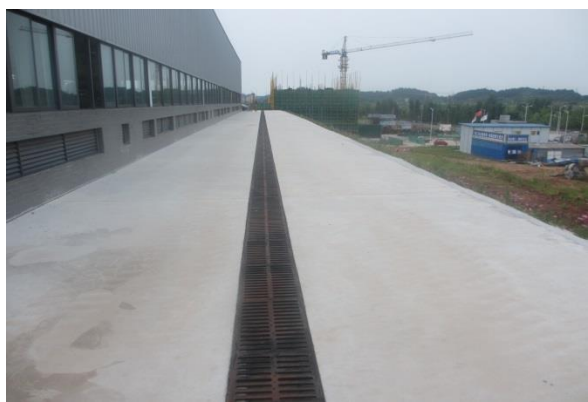
主体建筑区排水沟
